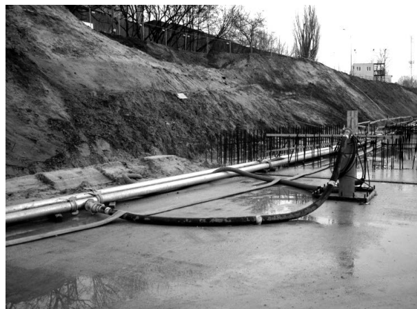
Rys. 4. Elementy systemu odprowadzenia wody z wykopu
