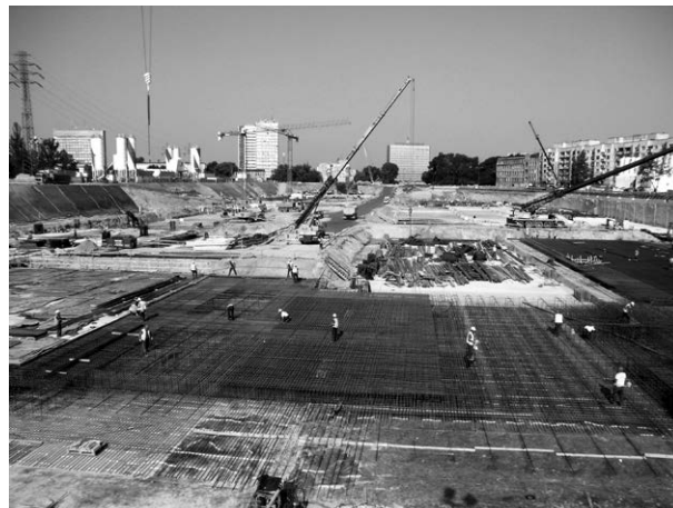
Rys. 2. Realizacja płyty pośredniej. Widok z wnętrza wykopu
