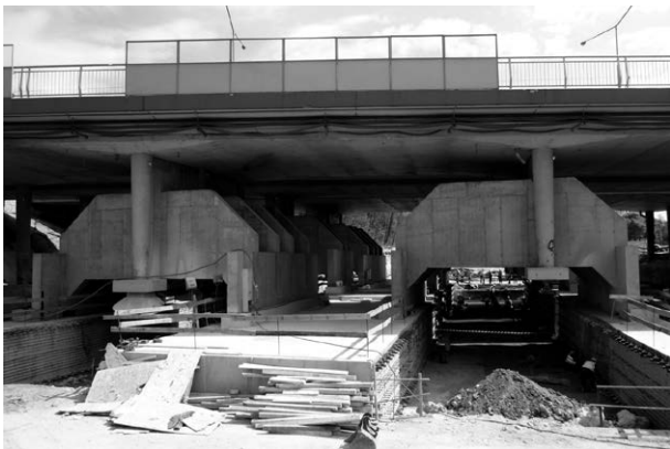
Rys. 8. Widok tymczasowych tarcz żelbetowych opartych na fragmentach płyty górnej tunelu kolejowego
