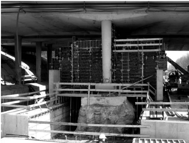
Rys. 7. Wykonywanie tymczasowych tarcz żelbetowych. Widoczna struktura pierwotnych fundamentów wiaduktu
