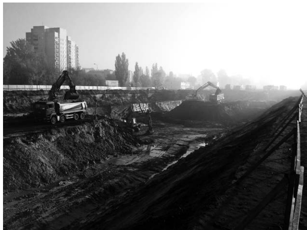
Rys. 1. Realizacja wykopu powyżej lustra wody gruntowej
