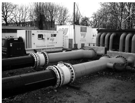
Rys. 5. Stacja pomp oraz przyłącze rurociągów tłocznych średnicy 600 i 1000 mm odprowadzających wodę poza teren budowy do systemu cieków wodnych
