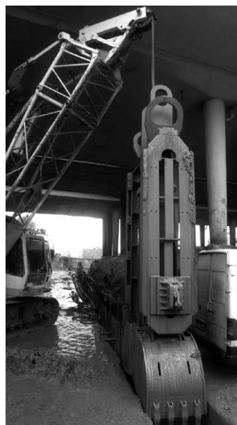
Rys. 6. Wykonywanie tymczasowych tarcz żelbetowych
